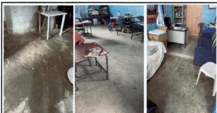
Foto 5: sustitución de piso cerámico en cocina por estar en mal estado y aulas.
