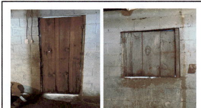
Foto 4: sustitución de puertas y ventanas de cocina y biblioteca
