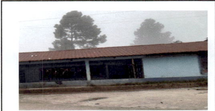
Foto1: Sustitución de lámina por oxidación y filtración de agua en tiempo de lluvia.
