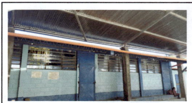
Foto 6: sustitución de tubería de agua pluvial por filtración de agua en pasillos de aulas.
