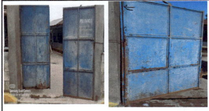
Foto 2: sustitución de portón por oxido y deterioro.
