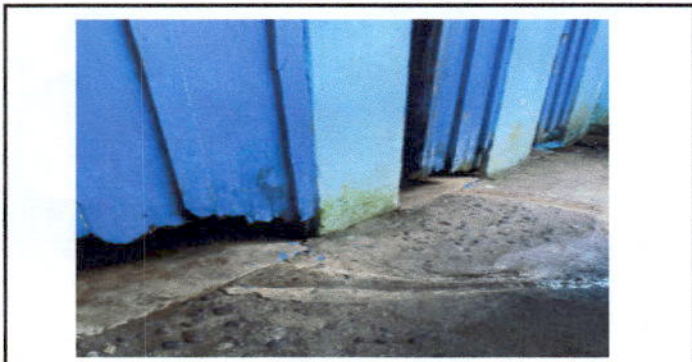
Foto 3: servicios sanitarios: cambio de puertas en mal estado por deterioro
